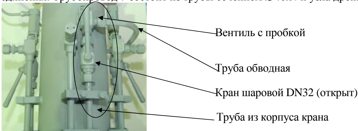
Рисунок 5 – Узел дренажный
